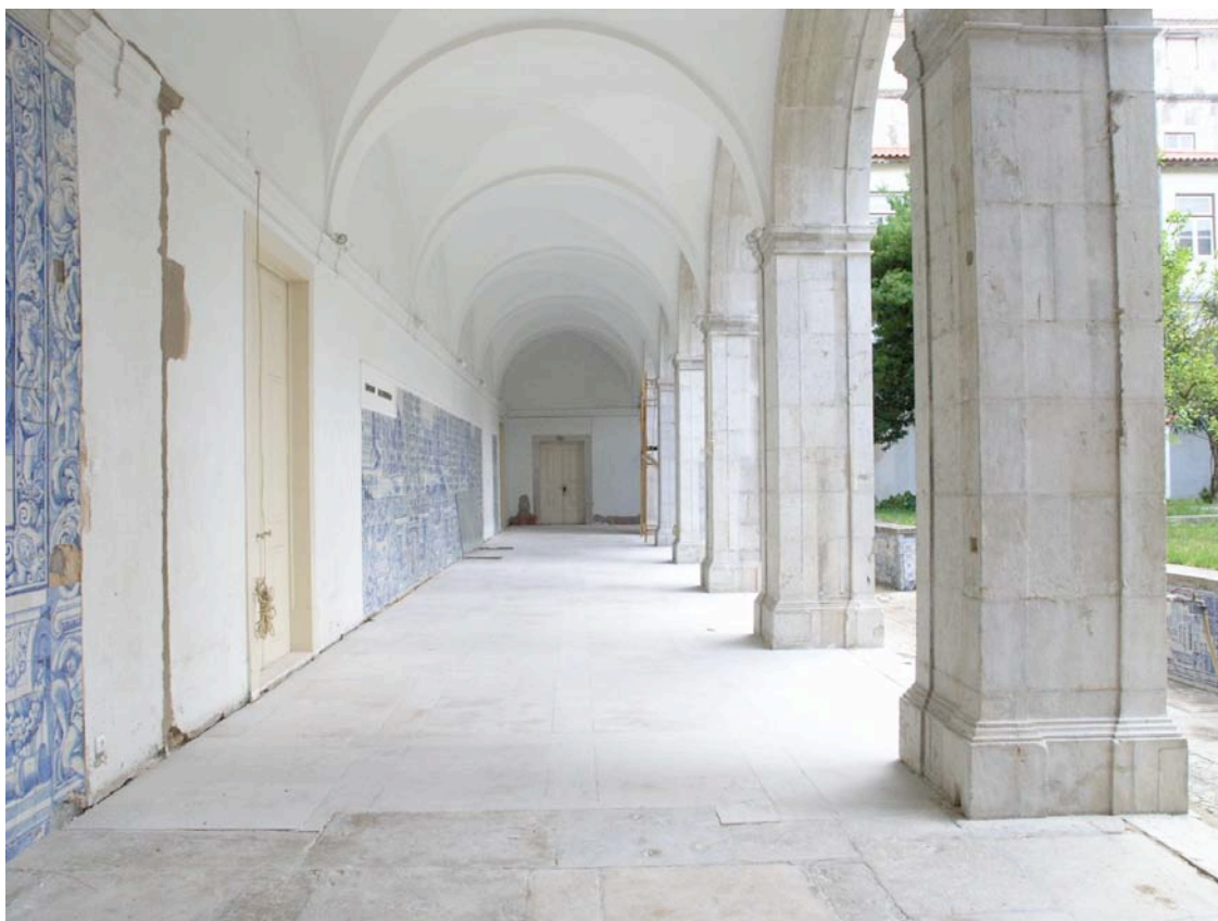
Figura 1 – Claustro do Convento de Jesus / Academia das Ciências de Lisboa. Ala Este, prospectada mas não escavada, após pavimentação..
